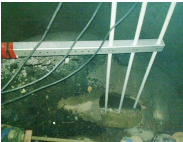
Fig. 8 Plasseringseksempel fremmedvannsovervåkning i renne med brakett
